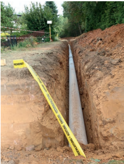
Die neue Leitung weist eine Betonummantelung auf, die vor felsigem Untergrund und Wurzeln schützt.
