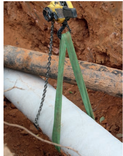
Die alte und die neue Leitung: Durch die turnusmäßige Sanierung erhöht sich nun die Transportkapazität des Abschnitts.
