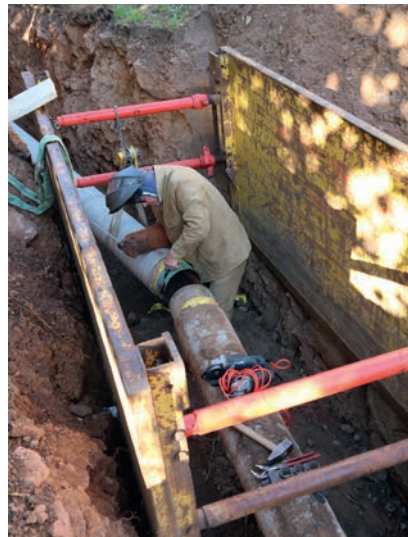
Die Leitungsabschnitte werden von einem Schweißer mit viel Berufserfahrung zusammengefügt.
