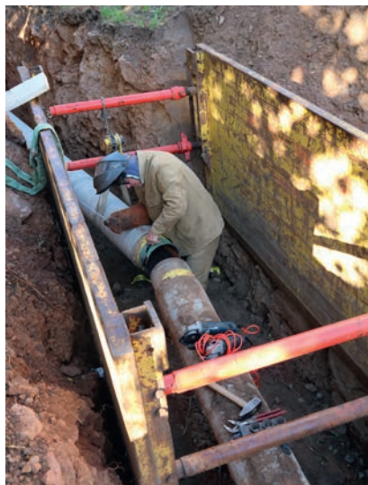
Die Leitungsabschnitte werden von einem Schweißer mit viel Berufserfahrung zusammengefügt.
