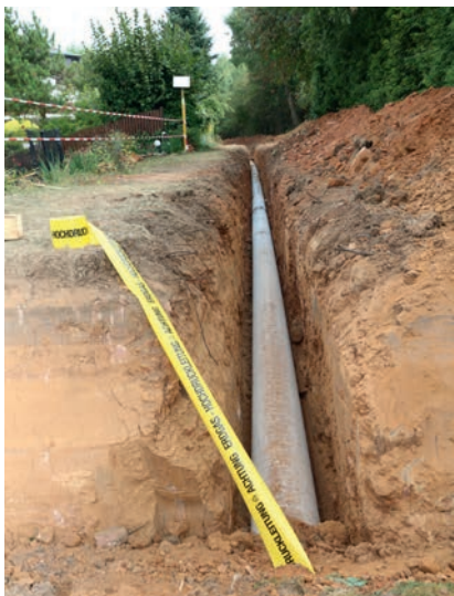
Die neue Leitung weist eine Betonummantelung auf, die vor felsigem Untergrund und Wurzeln schützt.
