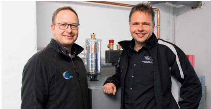
Karosserie- und Lackierermeister Peter Krauss (rechts) aus Gelnhausen-Hailer spart mit dem WärmeService von MainKinzigGas bares Geld. Energieberater und Vertriebsspezialist Andreas Bräuning stand ihm in Sachen Contracting zur Seite.
